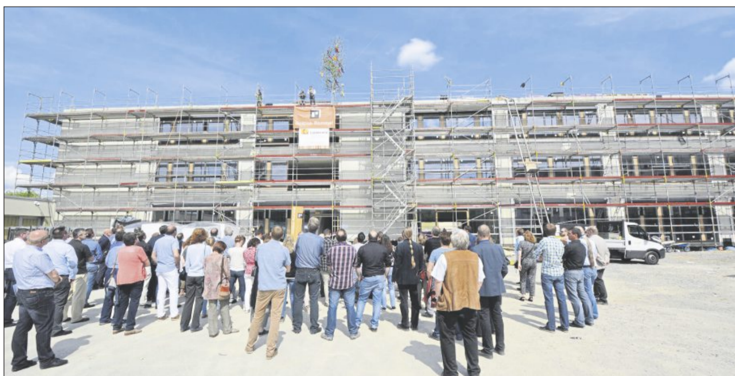
Das Richtfest des Burg-Gymnasiums fand bei strahlendem Sonnenschein statt.
