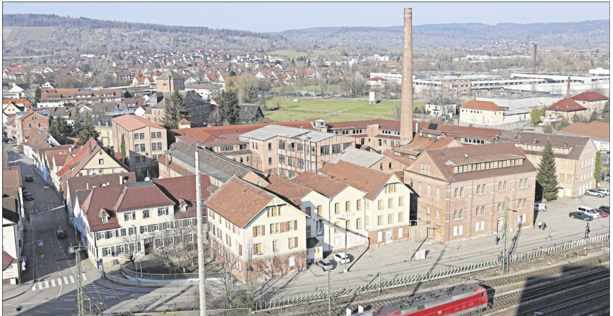
Rund um den Kamin gruppieren sich auf dem ehemaligen Breuninger-Areal die Gebäude, die von Mitte Januar an nach und nach abgebrochen werden. Der Kamin selber soll in diesem Fall nicht gesprengt, sondern aus Sicherheitsgründen ganz konventionell Stück um Stück abgetragen werden. Archivfoto: Habermann
