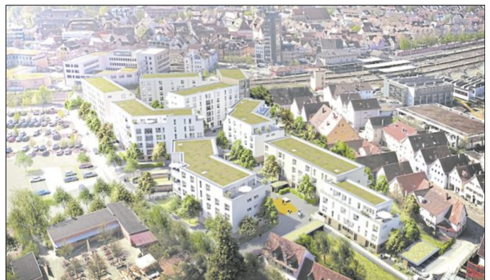
Ein Eindruck von der künftigen Bebauung auf dem ehemaligen Breuninger-Areal. Entstehen soll ein Quartier mit rund 230 Mietwohnungen, die noch vor Baubeginn an die R+V Lebensversicherung AG verkauft werden sollen. Visualisierung: Instone Real Estate Development GmbH
